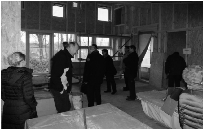
Der Gemeinderat machte sich ein Bild vom Baufortschritt des Anbaus an die Kinderkrippe
