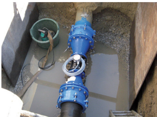
Einbau Wasserzähler im Rohrnetz
