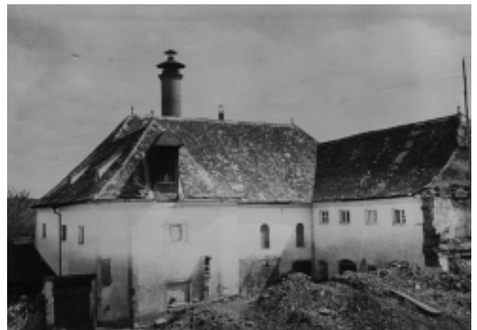
Die ehem. Steinacher Schlossbrauerei kurz vor ihrem Abbruch, Reste der abgebrochenen Torbögen sind noch zu erkennen.
