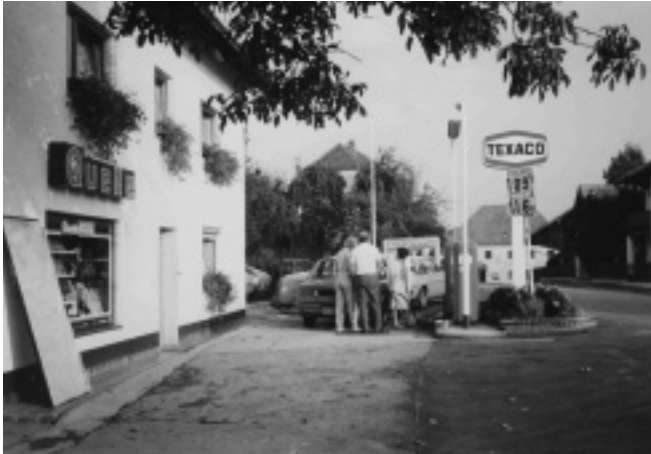
Die Werkstatt wurde in den Anbau eingerichtet, wo der voll funktionsfähige Ofen heute noch steht.
