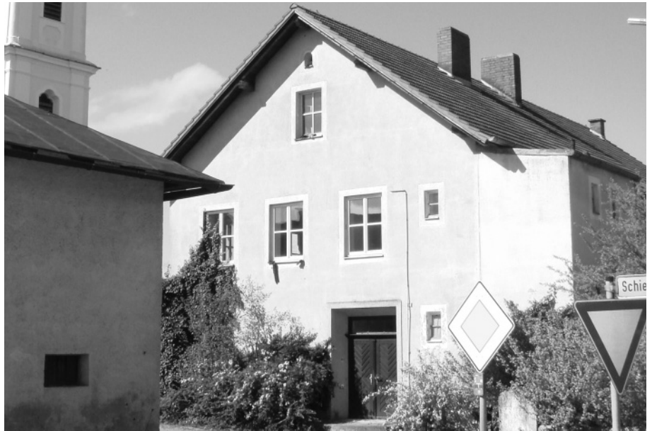
Das alte Schulhaus von Münster kurze Zeit vor dem Abbruch (Foto Lydia Ebenbeck)
