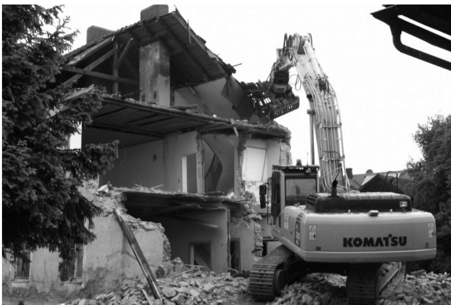
Nur wenige Tage dauerte Mitte Mai der Abbruch des Schulhauses in Münster (Foto Hans Agsteiner)
