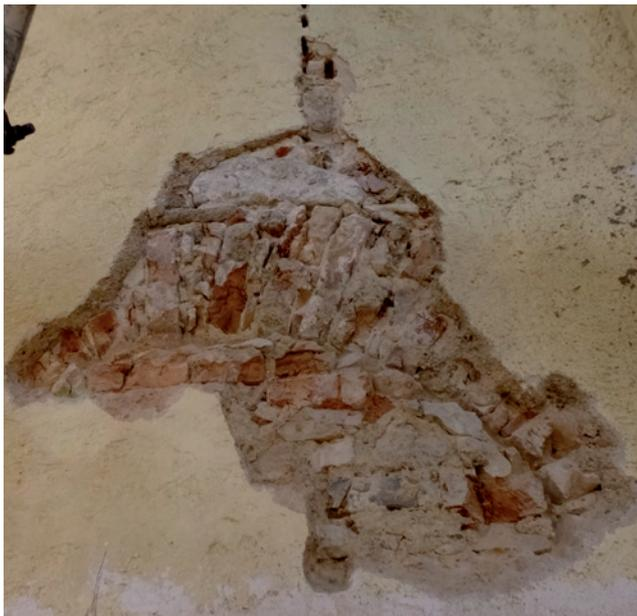
Abb. 4: Ein bei der Außenrestaurierung veranlasster Suchschlitz beim zugemauerten nördlichen Apsis-Fenster führte zu der Erkenntnis, dass die Fenster der Apsis oben rundbogig und damit wohl romanisch sind.
