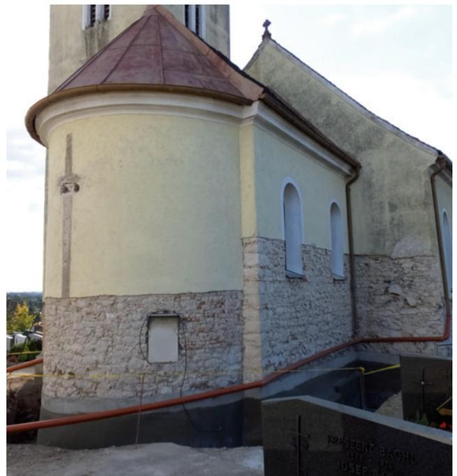
Abb. 3: Nachdem der Putz bis zur Höhe von 2 m abgeschlagen war, konnte man die romanische Bauweise der halbrunden Apsis und des eingezogenen Chorraums gut erkennen
