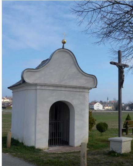
Ziegel errichtet, wobei der Anteil an Ziegel überwiegt. Tür- und Fenstereinfassung, sowie Unterbau des umlaufenden Traufgesimses und Schweifgiebel sind vollständig aus Ziegel erstellt.
