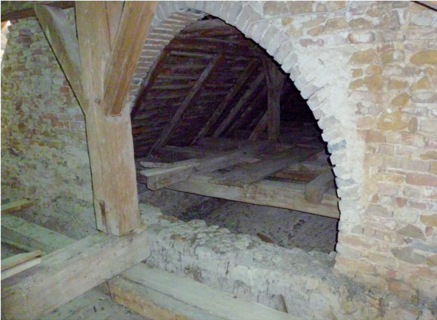
Abb. 8 Dem Baustil der Gotik zuzurechnen ist der spitzbogige Durchgang in der östlichen Giebelwand (Foto Manfred Danner, 2015).
